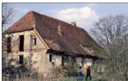
Haus Langhagen, vor dem Abriss.
