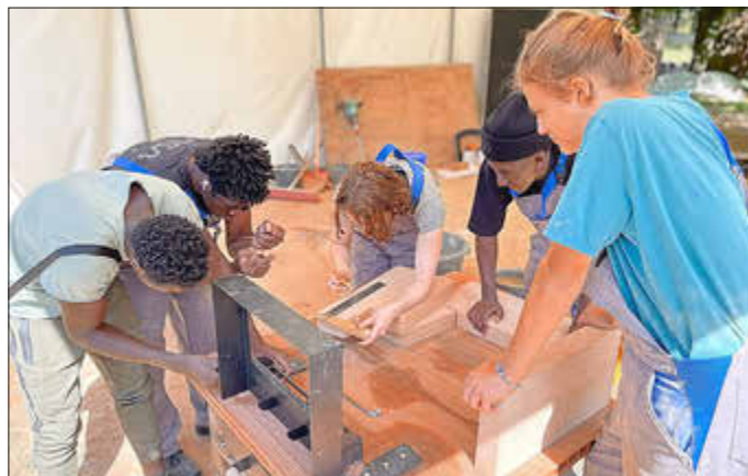
Der Grundstein ist gelegt. Jugendliche mit und ohne Migrationshintergrund bauen beim Wangelineer Workcamp „Erde, Feuer & Brot“ zusammen und unter Anleitung von Fachpersonal einen Lehmbackofen. An den ersten drei Tagen wird der Ofen aufgebaut und gedämmt, am vierten und fünften die Außenhülle gestaltet.
