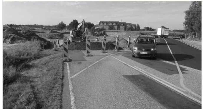
Der künftige Kreisel im Bau, der die Umgehungsstraße an die B 191 in Höhe der Tankstelle anbindet.
