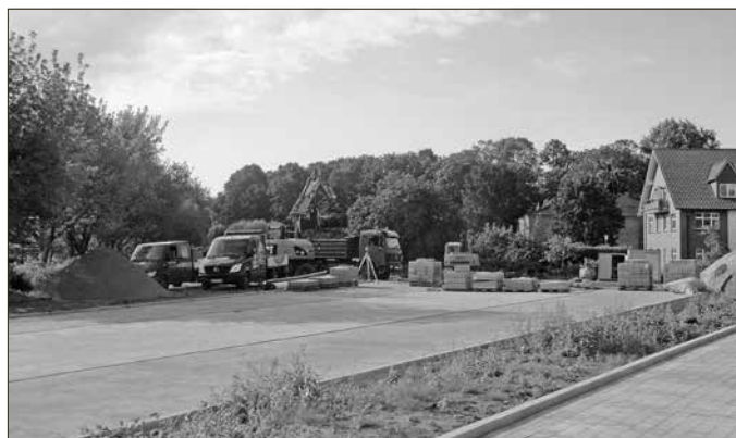
Der Parkplatz nimmt Gestalt an.
