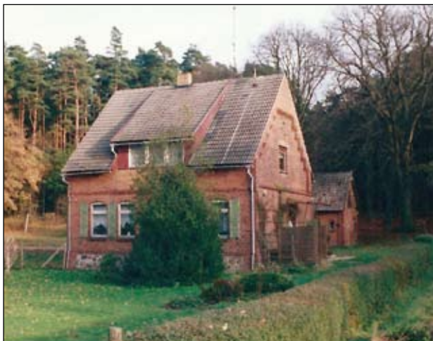
Forsthaus Teerofen nach Umbau.
