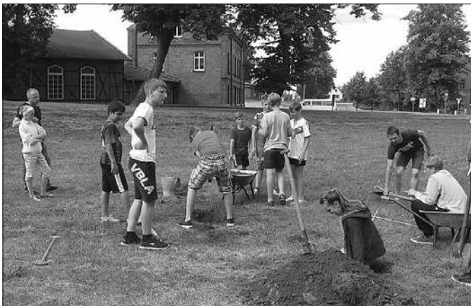
Das Ausgraben der Löcher für das Fundament erledigten die Jugendlichen vom Kinder- und Jugendzentrum.
