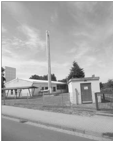
Hier wird das Blockheizkraftwerk eingebaut. Foto: W. H.
