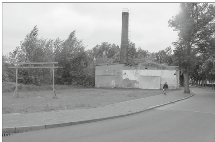
Die alte Wäscherei wird abgerissen, hier entsteht der Parkplatz. Foto: W. H.
