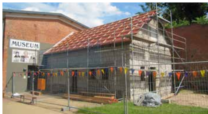
Auf dem Burghof wird eine neue öffentliche Toilettenanlage gebaut. Foto: W. H.
