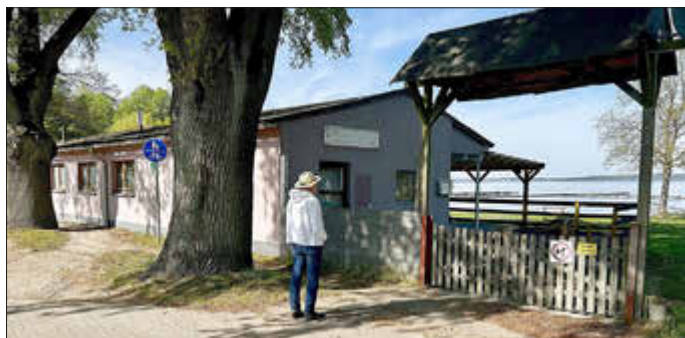
Ein Ort mit Geschichte vor dem Neustart: Das Strandbad erhält neues Leben durch schrittweise Sanierung. Foto: Jutta Sippel
