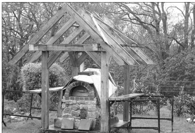
Jetzt fehlen nur noch die Dachsteine.
