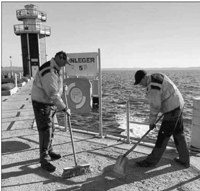
Mitarbeiter des Bauhofes sind schnell zur Stelle und beseitigen den Schaden.
