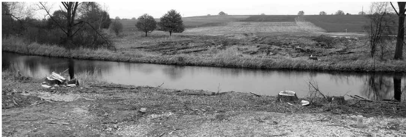
Blick auf die Trasse. Hier wird die Brücke über die Elde gebaut.
