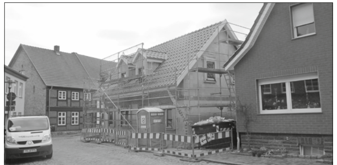
Neubau in der Stietzstraße.
