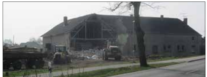
Abriss des alten Kindergartens an der Güstrower Chaussee
