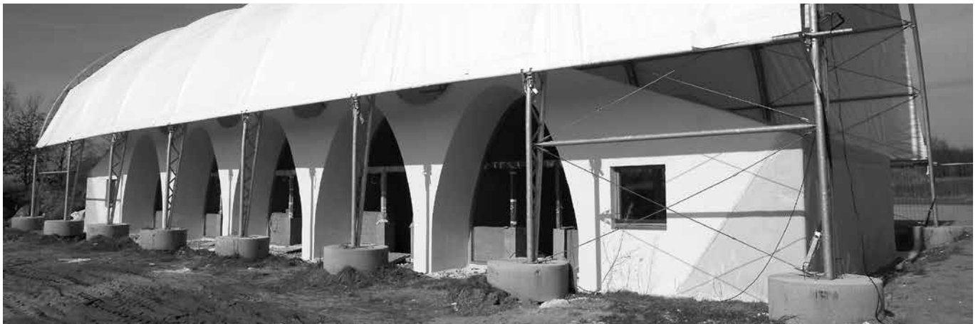
Die finale Bauphase des Strohballen-Gewölbehouses, das einen Meilenstein auf dem Gebiet des ökologischen Bauens bildet, beginnt - sobald es die Witterung zulässt. Foto: J. Dembski
