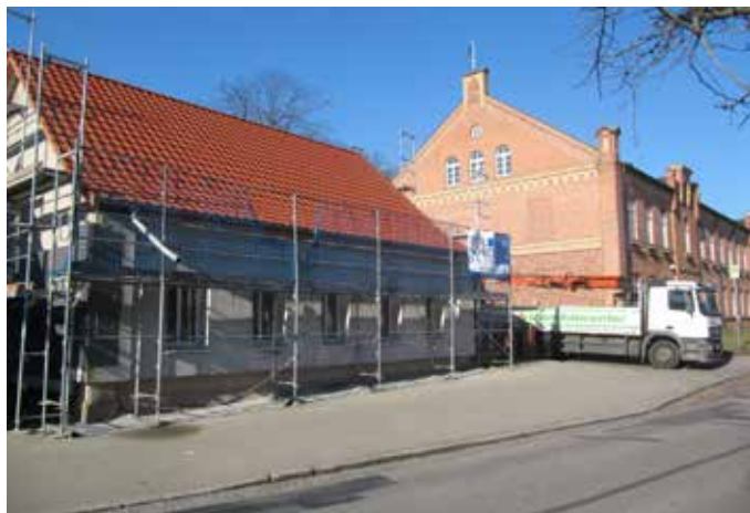
Das Nebengebäude der Kantor-Ehrich-Schule wird saniert. Foto: W.H.
