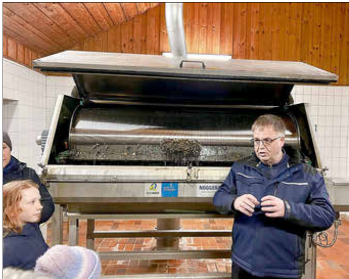
Im Rechen bleibt so einiges hängen, was nicht in das Abwasser gehört.
