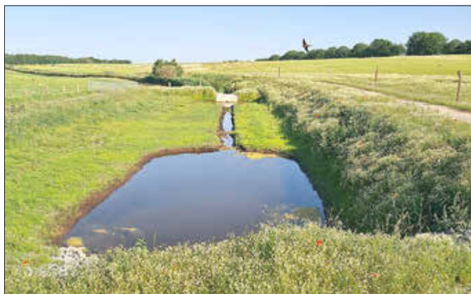
Das Regenrückhaltebecken in Erdbauweise.
