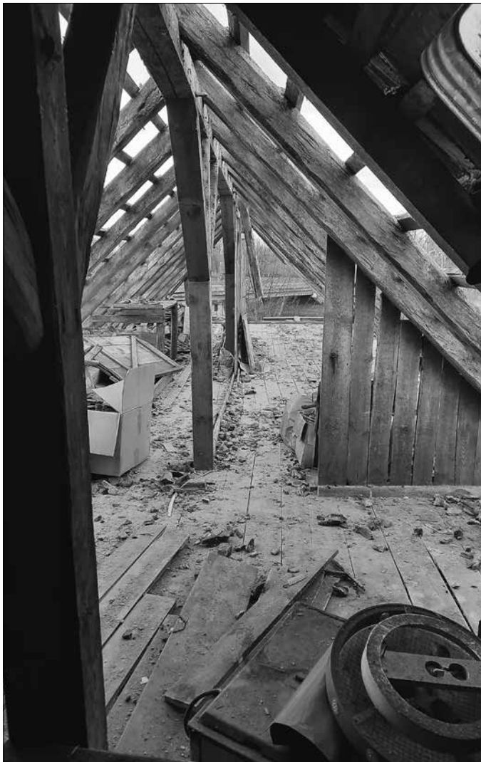
Ein Blick ins Dachgeschoss.
