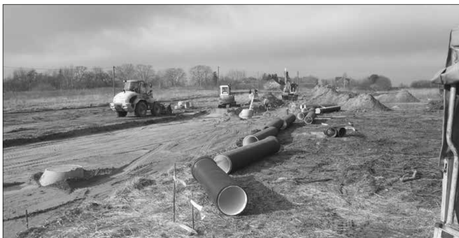
Die Wittstocker Firma Bugdorf verlegt zur Zeit im Plauer Entwicklungsgebiet die Versorgungsleitungen (Gas, Wasser, Abwasser, Telekom). Foto: W. H.
