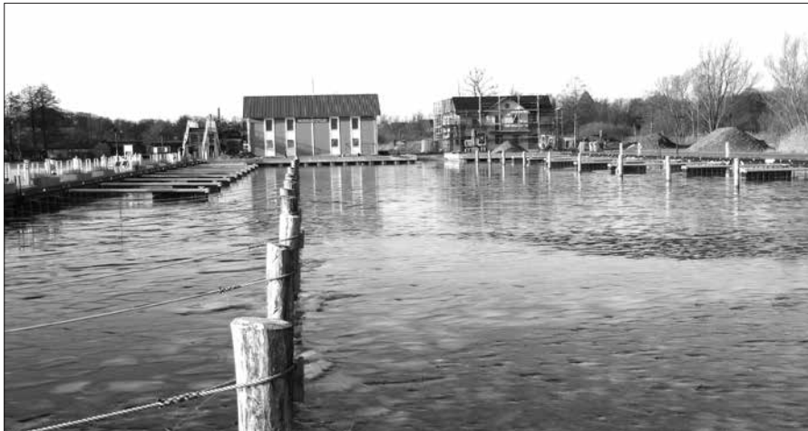
Neben der Wasserschutzpolizei ist das erste Funktionsgebäude des Hafens am Kalkofen rohbaufertig. Foto: W. H.
