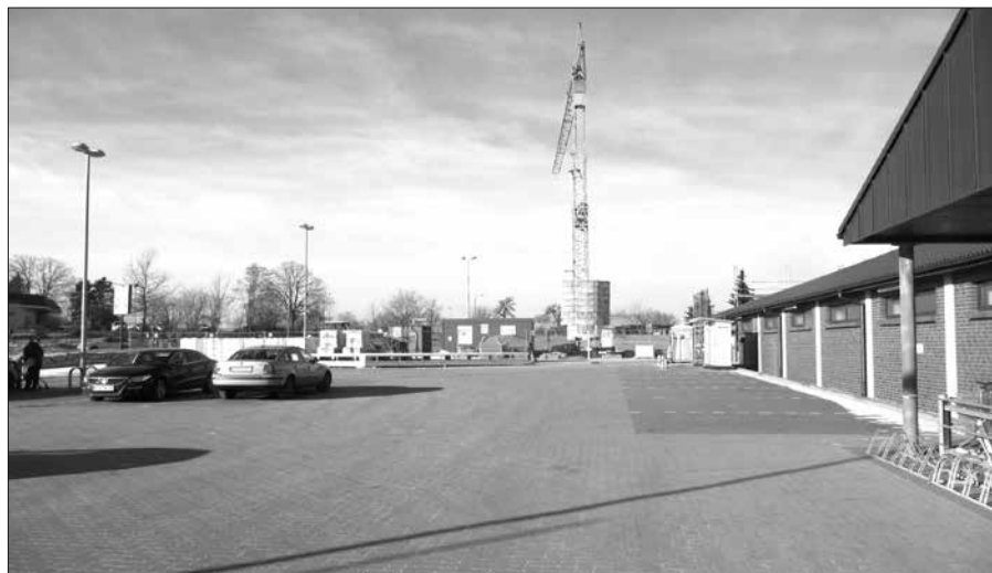
Am Aldi wird ein Getränkemarkt gebaut.
