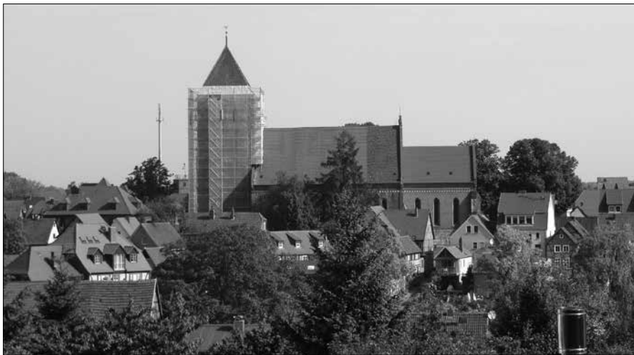
Die Außenhaut der Marienkirche ist saniert worden.
