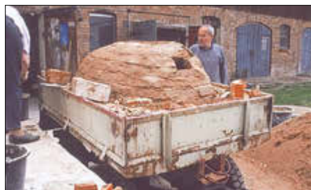
Rüger bei der Errichtung des fahrbaren Lehmbackofens (1999).
