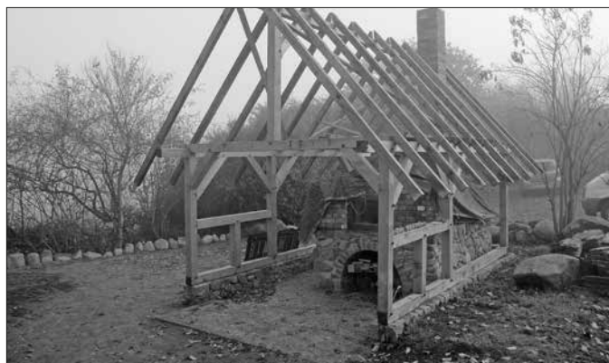
Der Backofen am Gnevsdorfer Lehmuseum im Bau.
