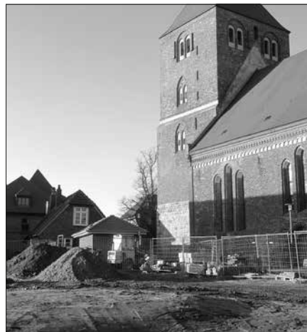
Das alte Toilettenhaus wurde abgerissen.
