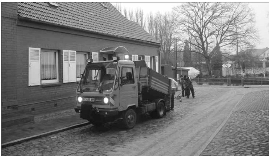
**Der städtische Bauhof war am 10. Dezember wieder einmal unterwegs, um die Straßen in der Innenstadt, hier die Fahrbahn der Stietzstraße, abzusanden. Durch die Kehrmachine wird der Sand zwischen den Pflastersteinen herausgefegt. Dadurch besteht die Gefahr, dass sie lose werden. Durch das Absanden wird das verhindert.**
