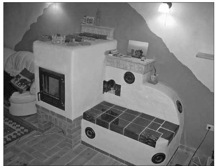
Handwerklich gefertigter Lehmgrundofen, Planung: Jörg Finger
