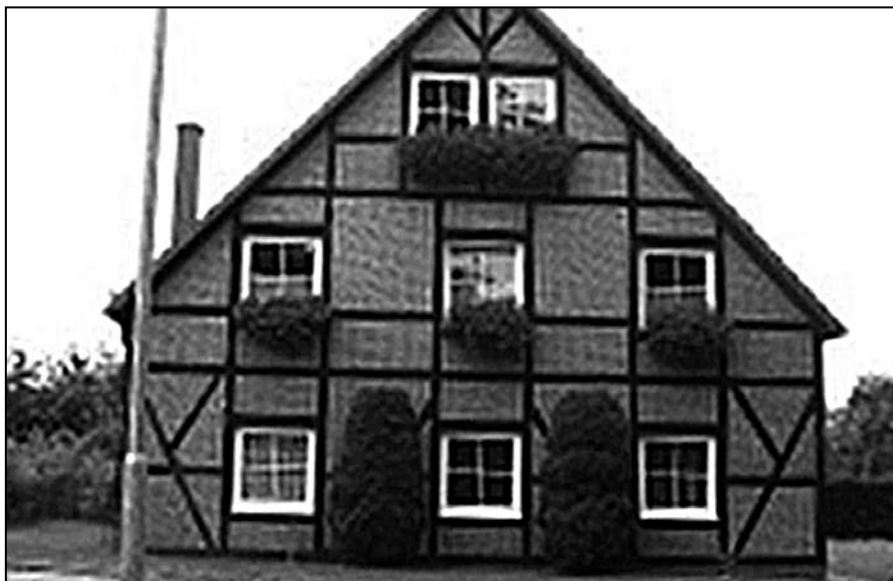
Ein positives Beispiel: ein Haus am Ziegeleiweg
