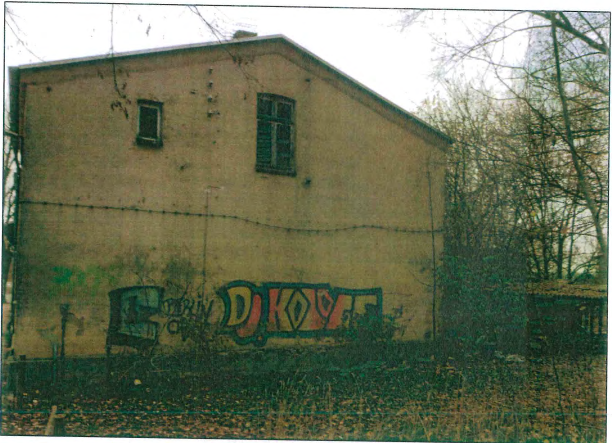
Abbildung 1: Betriebsgebäude der ehemaligen Wäscherei; Baukonzept Neubrandenburg GmbH 2013
