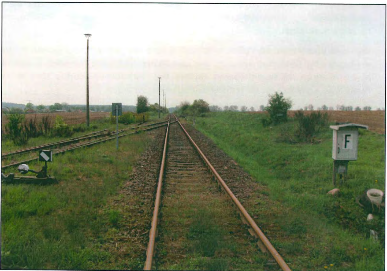
Abbildung 4: Die Gleisanlage trennt das Bebauungsplangebiet räumlich. Im Randbereich
