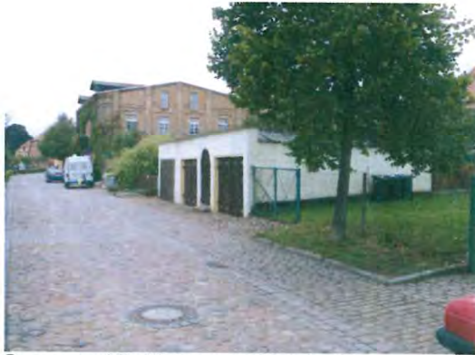
Garagen und Freifläche an der Strandstraße
