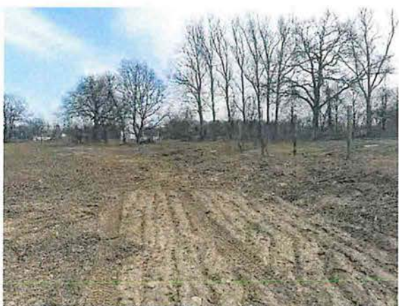
Abbildung 8: Gerodete Flächen entlang der südöstlichen Plangebietsgrenze entlang der Zaunanlage der Freiwilligen Feuerwehr, 14.03.2022.
