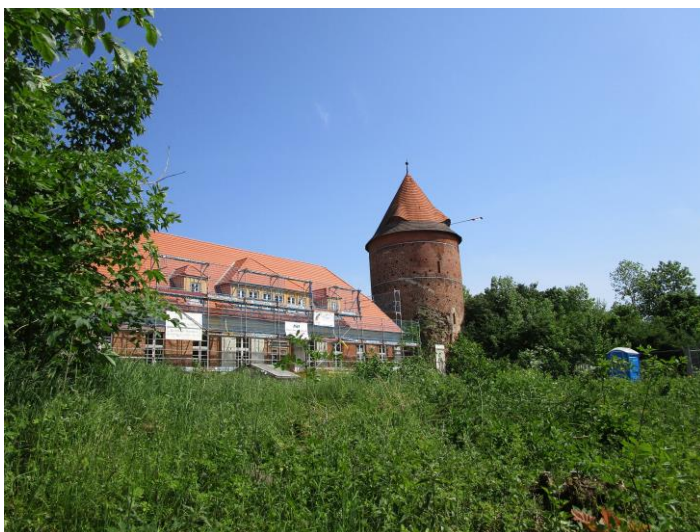
Bauvorhaben „Haus des Gastes“
